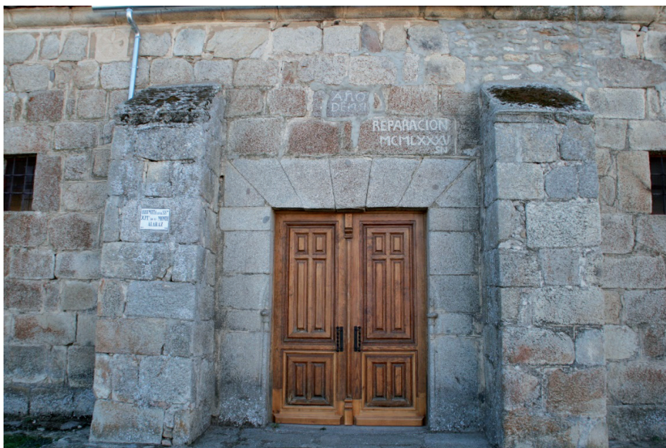
Portada de la ermita del Cristo del Monte con diversas inscripciones que datan las reparaciones del templo.
