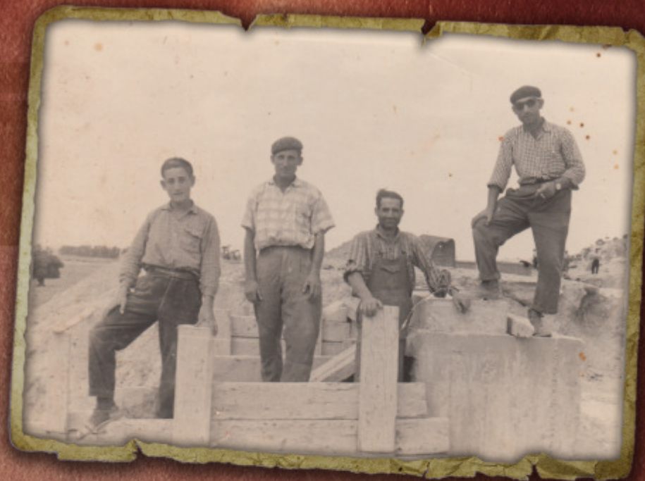
Construyendo el canal Diputación: Ángela Gallego Vega
